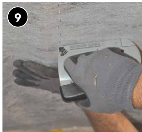
9 En el caso de las órdenes de trabajo que requieren el uso de red, asegure una capa lisa de red en la parte inferior de las viguetas del piso.
