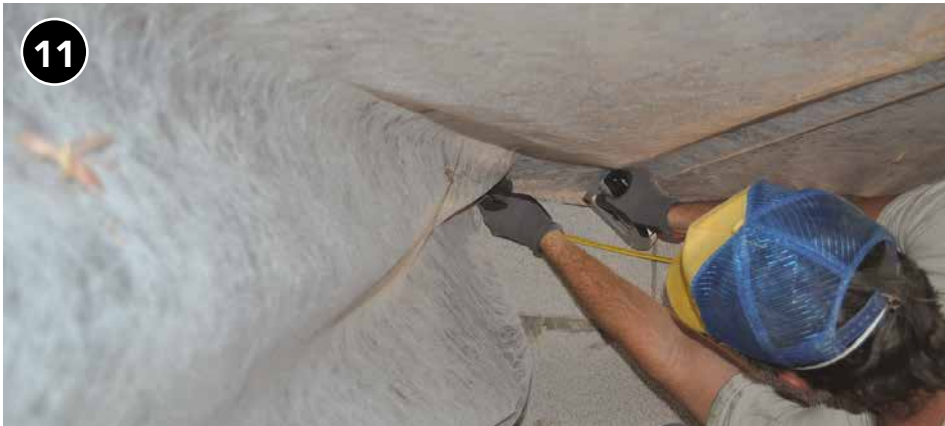
Cubra toda la cavidad para garantizar una cobertura de aislamiento continua y evitar que el aislamiento se salga por los extremos.
