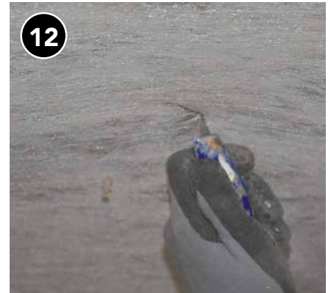
Corte el orificio de acceso para introducir el tubo de llenado.
