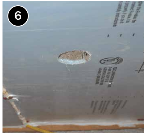
6 Llene la cavidad completamente de acuerdo con la densidad requerida en la orden de trabajo.
