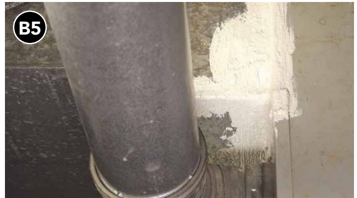
B5 Aplique resina mástic adicional sobre la malla y la cinta, extendiéndola al menos 1 pulgada más allá de los bordes de la cinta en todas las direcciones.
