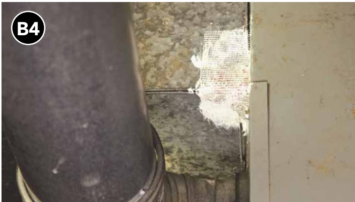
B4 Empuje la malla de fibra de vidrio en la resina mástic.
