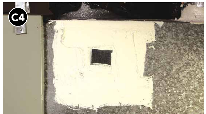
C4 Aplique resina mástic adicional sobre la malla, extendiéndola al menos 1 pulgada más allá de la cinta y la unión, en todas las direcciones.
