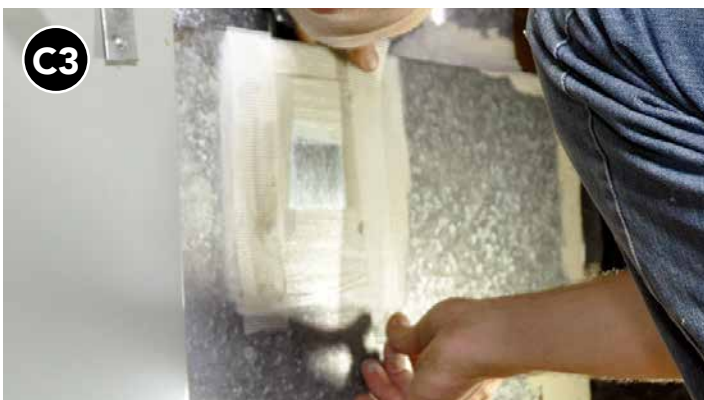
C3 Aplique resina mástic sobre los bordes y sujetadores del parche y empuje la malla de fibra de vidrio dentro.
