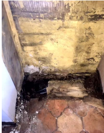
Expose the Drywall
